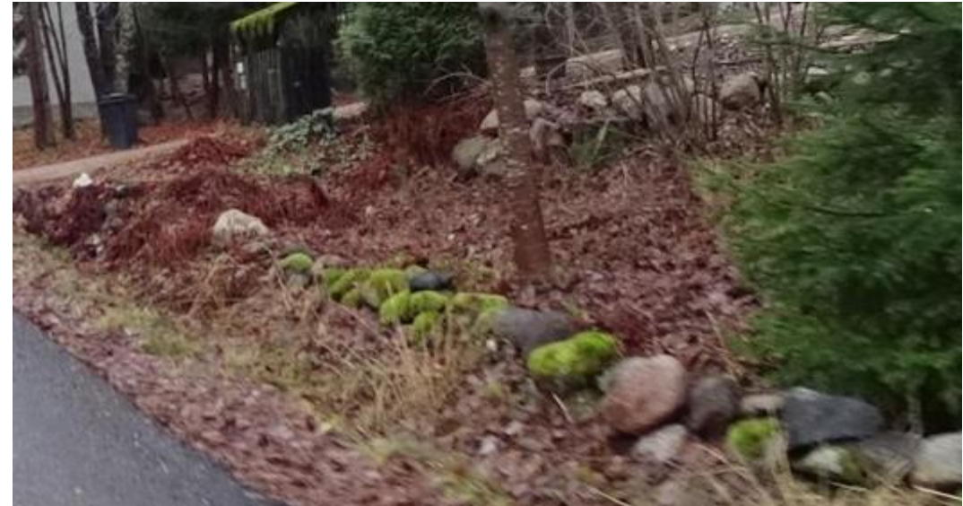
Kivrakennelma Pohjoisen Heikelintie 22
