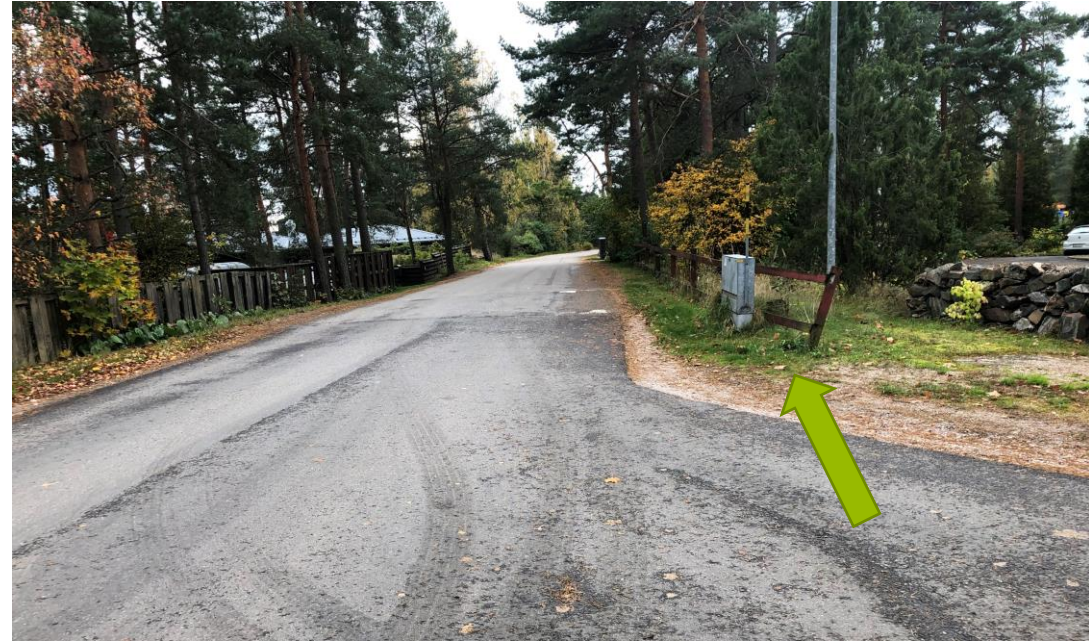
Puinen aita ja sähkökaappi, Kavallintie 18
