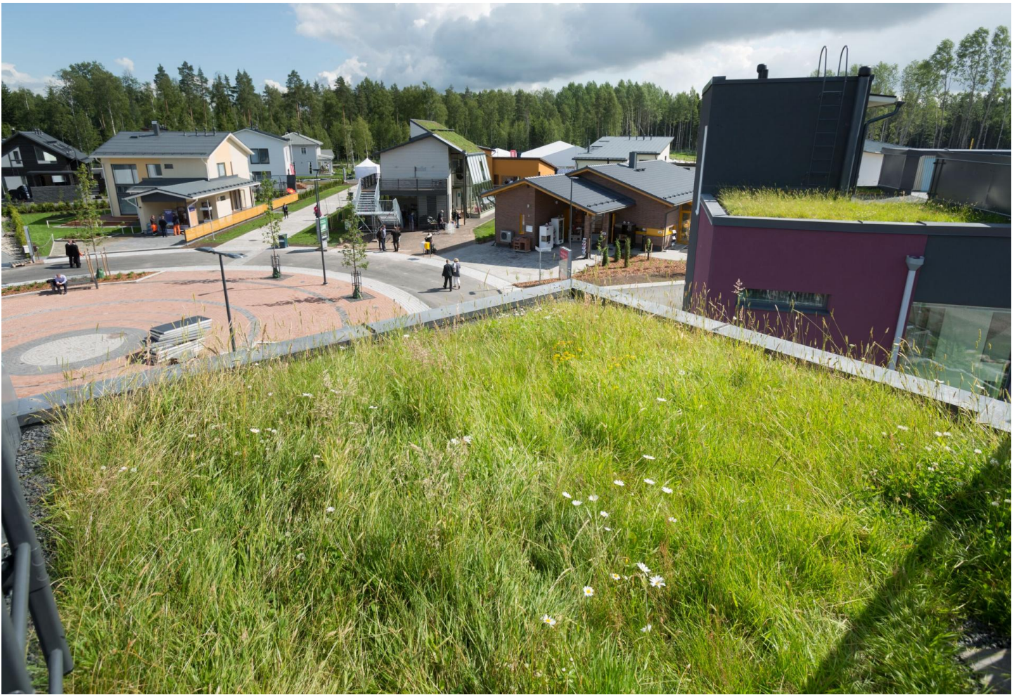
Kuva 10. Viherkatot edistävät hulevesien hallintaa kaupunkiympäristössä. Kuva: HSY/ Kai Widell.
