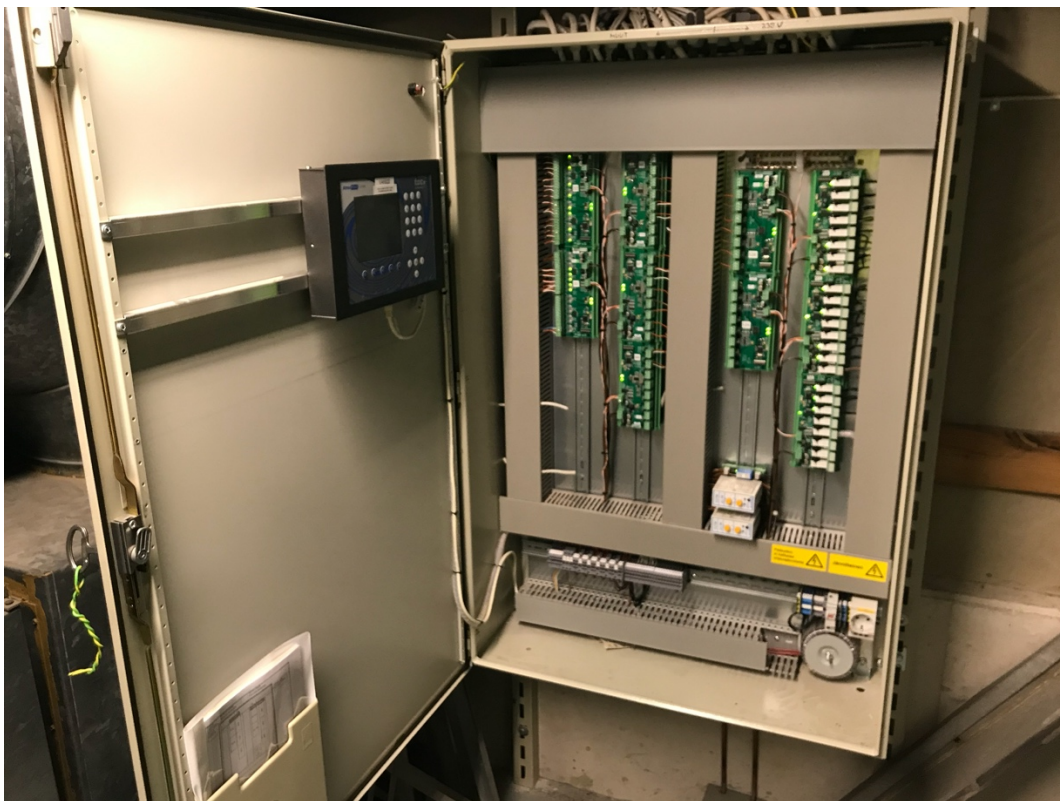
Rakennusautomaatiojärjestelmän alakeskus
