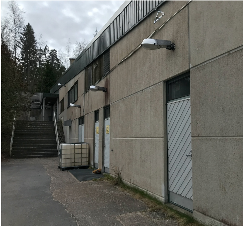
Elohopealampuilla varustettuja ulkovalaisimia.
