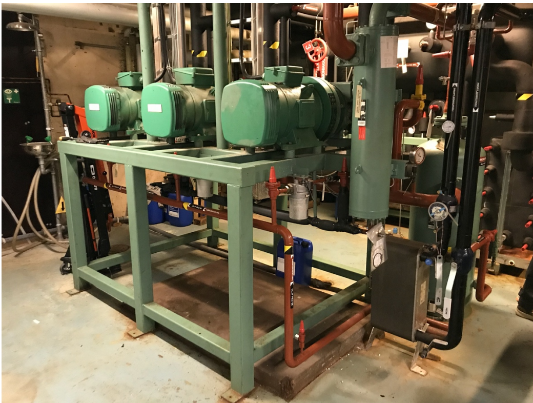
Kylmäjärjestelmän kompressorit
