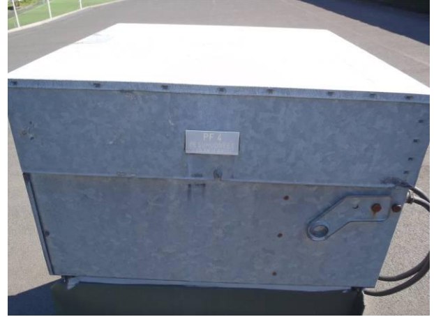
Kuva L4. Alkuperäinen pukuhuoneen pesuhuonetta palveleva huippuimuri vesikatolla.
