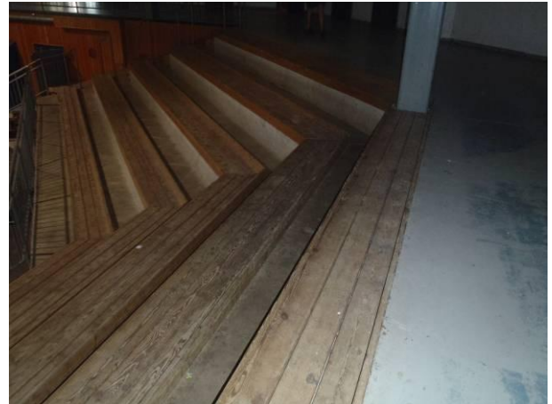
Kuva R15. Katsomon puiset penkit ovat pinnoiltaan kuluneet ja tummuneet.
