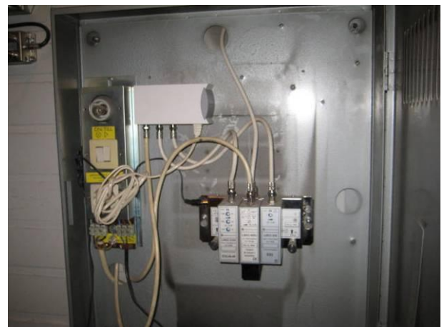
Kuva S6. Nykyinen antennijakokaappi.
