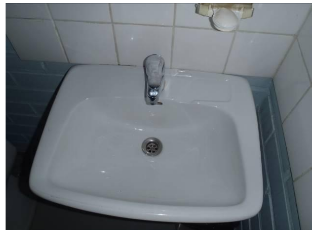
Kuva L6. Uusittu 1-ote pesuallashana (Oras).
