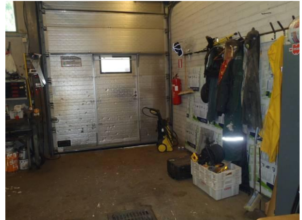
Kuva R9. Nosto-ovissa on runsaasti kolhuja.
