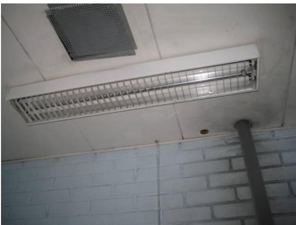
Kuva S3. Alkuperäisiä loistevalaisimia
