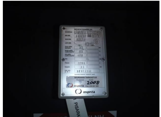
Kuva L9. Jäähdytyskoneikon rekisterikilvessä on merkitty seuraavan määräaikaistarkastuksen ajankohdaksi 8/2008.
