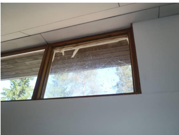
Kuva R8. Pukuhuoneen rikkoutunut ikkuna on korjattu väliaikaisesti pleksilasilla.
