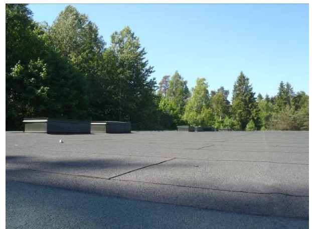
Kuva L10. Savunpoistoluukkuja vesikatolla.
