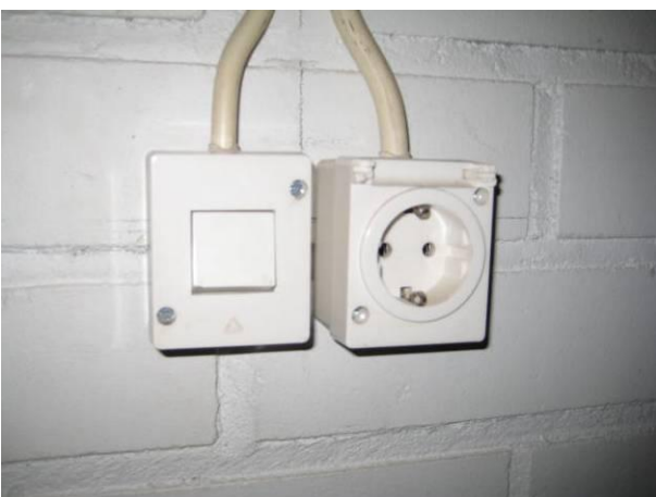
Kuva S9. Pääkeskustilan pistorasiakansi on rikki
