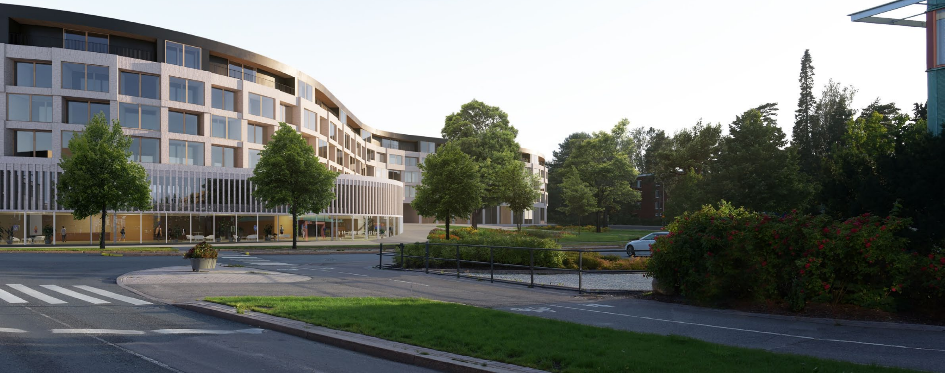
Tunnelitien ja Kauniaistentien risteys, näkymä etelään Korsningen mellan Tunnelvägen och Grankullavägen, utsikt mot söder
