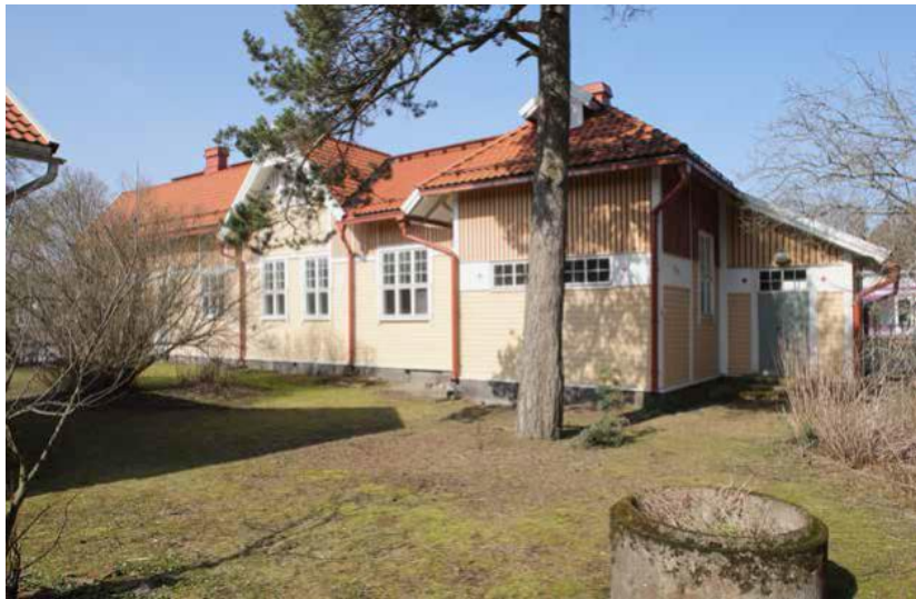
Kuva 4. Asemarakennuksen sisäpihaa. Ark-byroo Oy, 2020.
