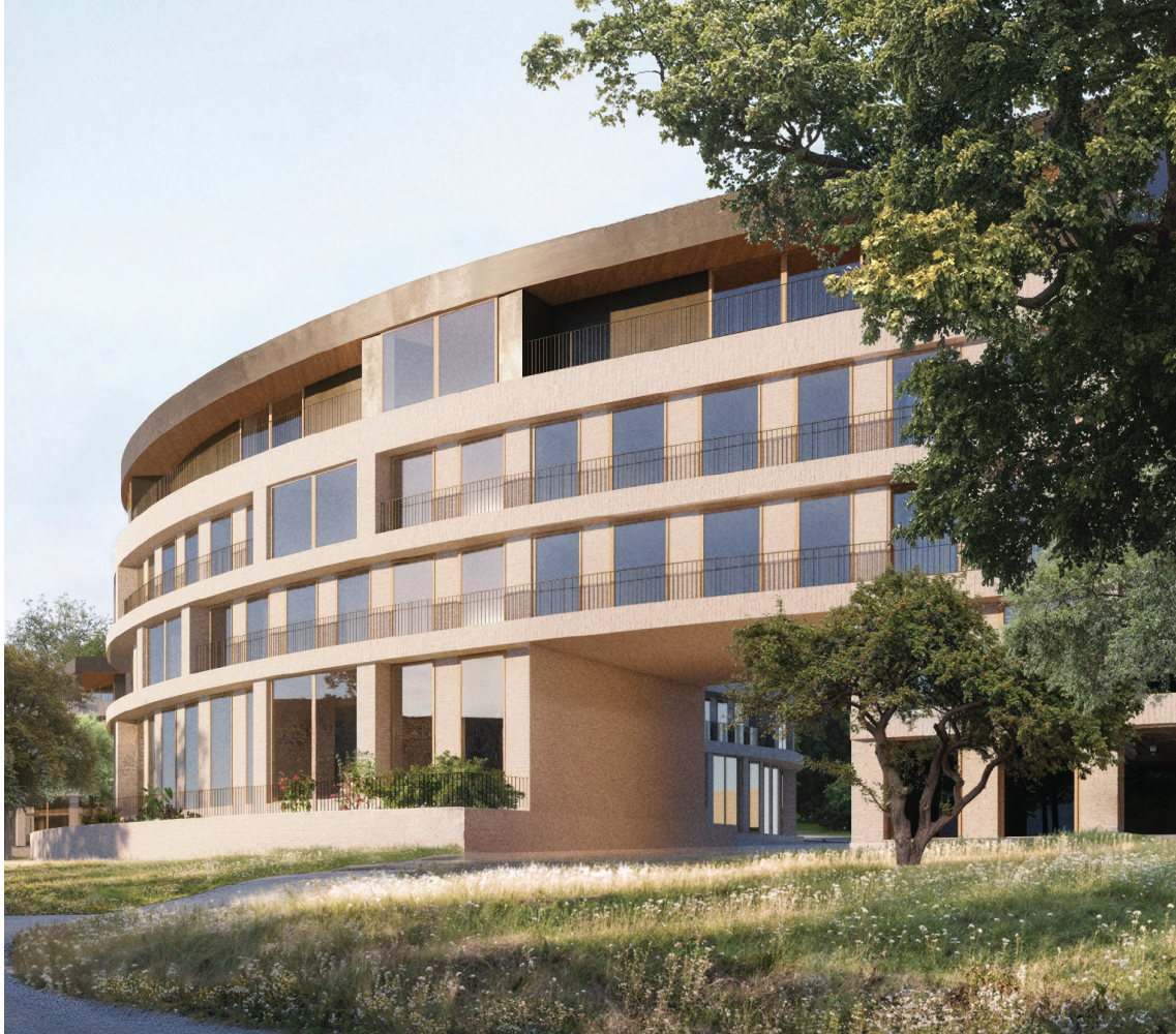
Kuva 9. Massan lävistävät kulkureitit kallistavat rakentamista merkittävästi. Kulkuaukkojen yläpuolelle jäävät asuntoneliöt ovat toisaalta hankalia toteuttaa ilman rakennettavan alapohjarakenteen vuoksi. Viitesuunnitelman päivityksessä kulkuaukkoja madallettiin, jolloin saatiin myytäviä asuntoneliöitä enemmän.
